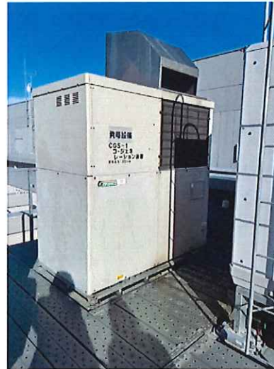
図2 天然ガスを熱源とする コージェネレーション（35kW）
