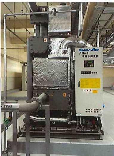
図3 ソーラー吸収式冷温水発生機
